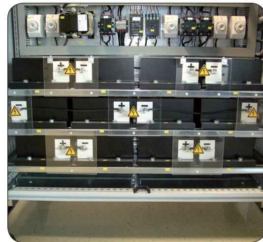
Energiespeicher auf Basis von Doppelschicht-Kondensatoren
