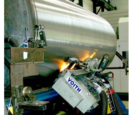
mobile Schleifeinheit für Walzeninstandsetzung in der Papierherstellung (Voith Paper Services / IWU)
